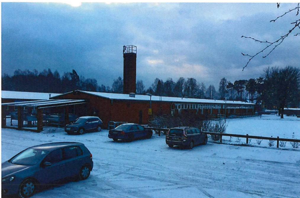
Bild tagen mot sydöst inne på parkeringen i norra delen av befintligt skolområde.
