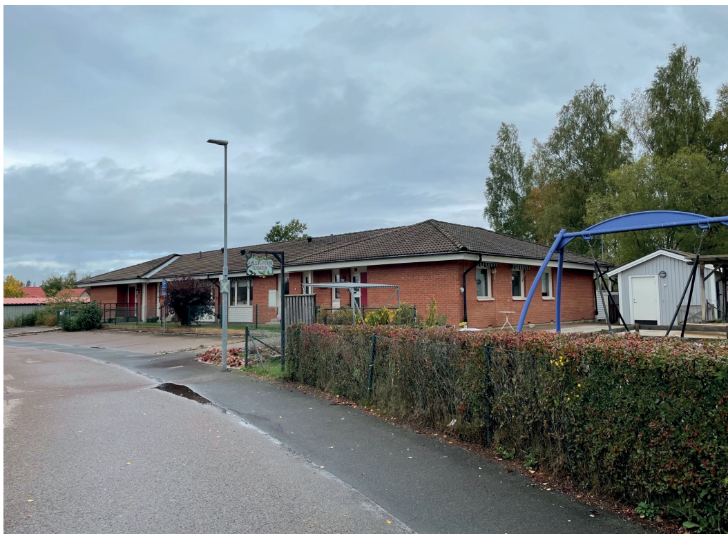
Figur 6. Foto på befintlig byggnad som använts till förskoleverksamhet.
