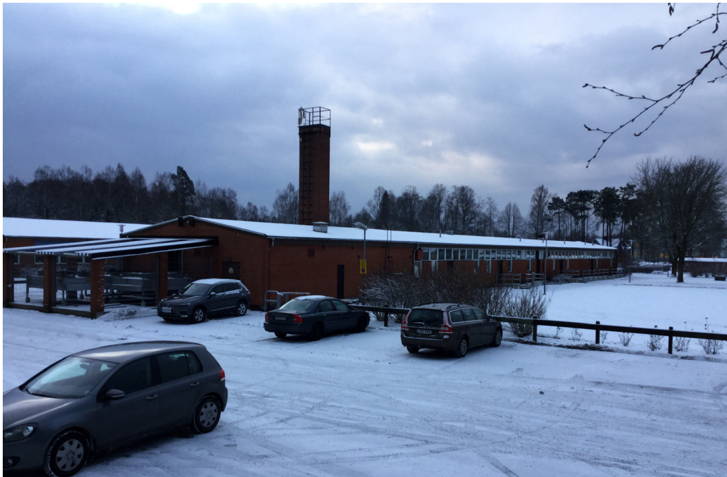
Bild tagen mot sydöst inne på parkeringen i norra delen av befintligt skolområde.
