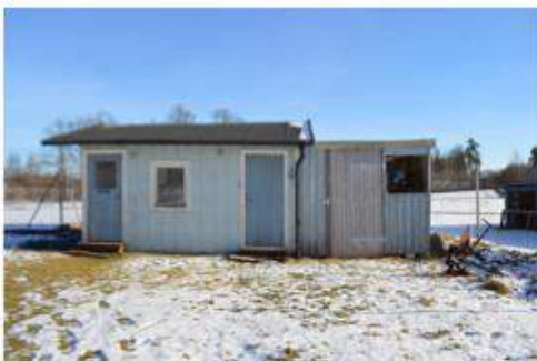
Äldre omklädningsrum/ Förråd
