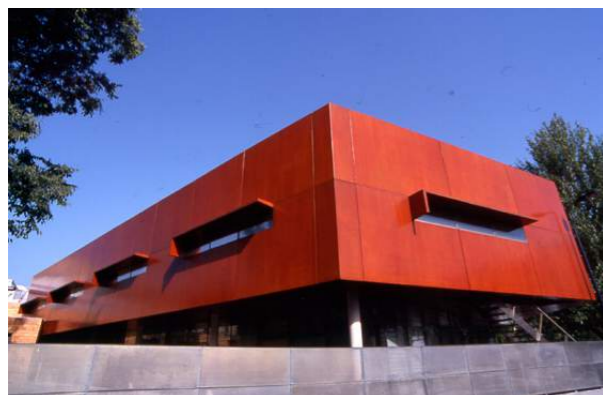
Fasader med kulörthet gjuts mot form och behandlas med typ Piero Lingots Prelo Metal
