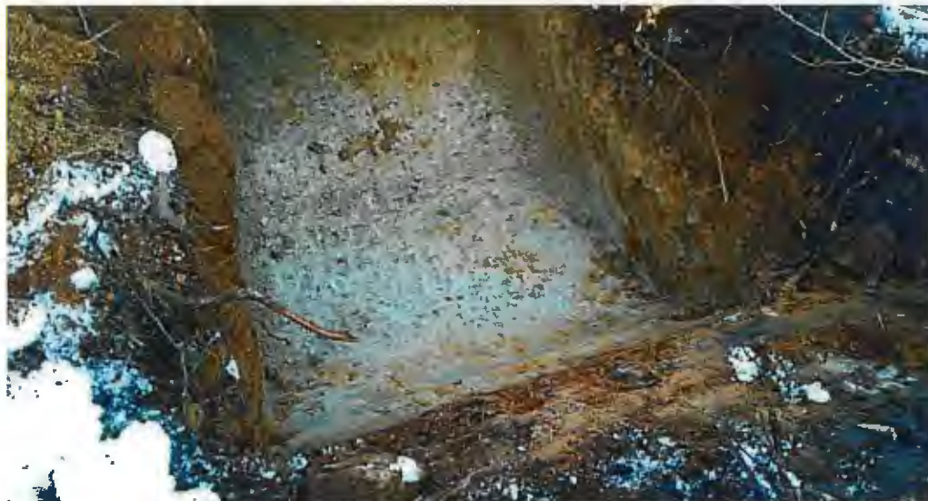
Provgrop 4. Bilden visar schaktbotten utan större stenar.
